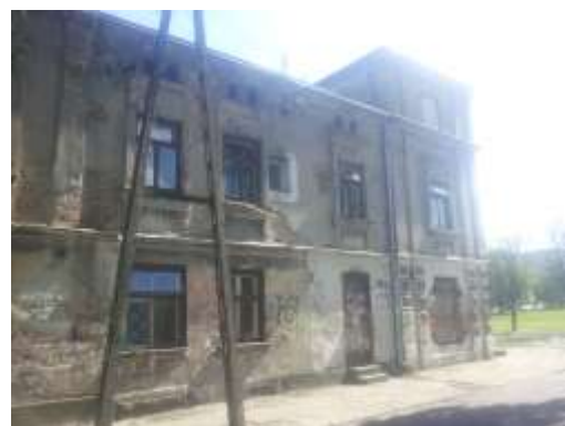
Elewacja od strony ulicy Chopina
