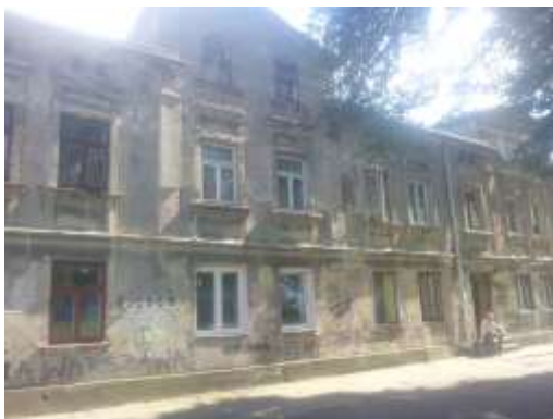
Elewacja od strony ulicy Chopina
