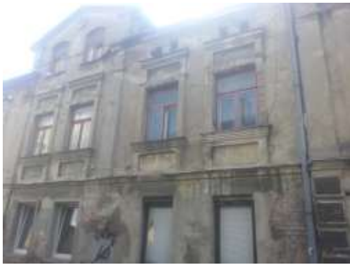
Elewacja od strony ulicy Ciasnej
